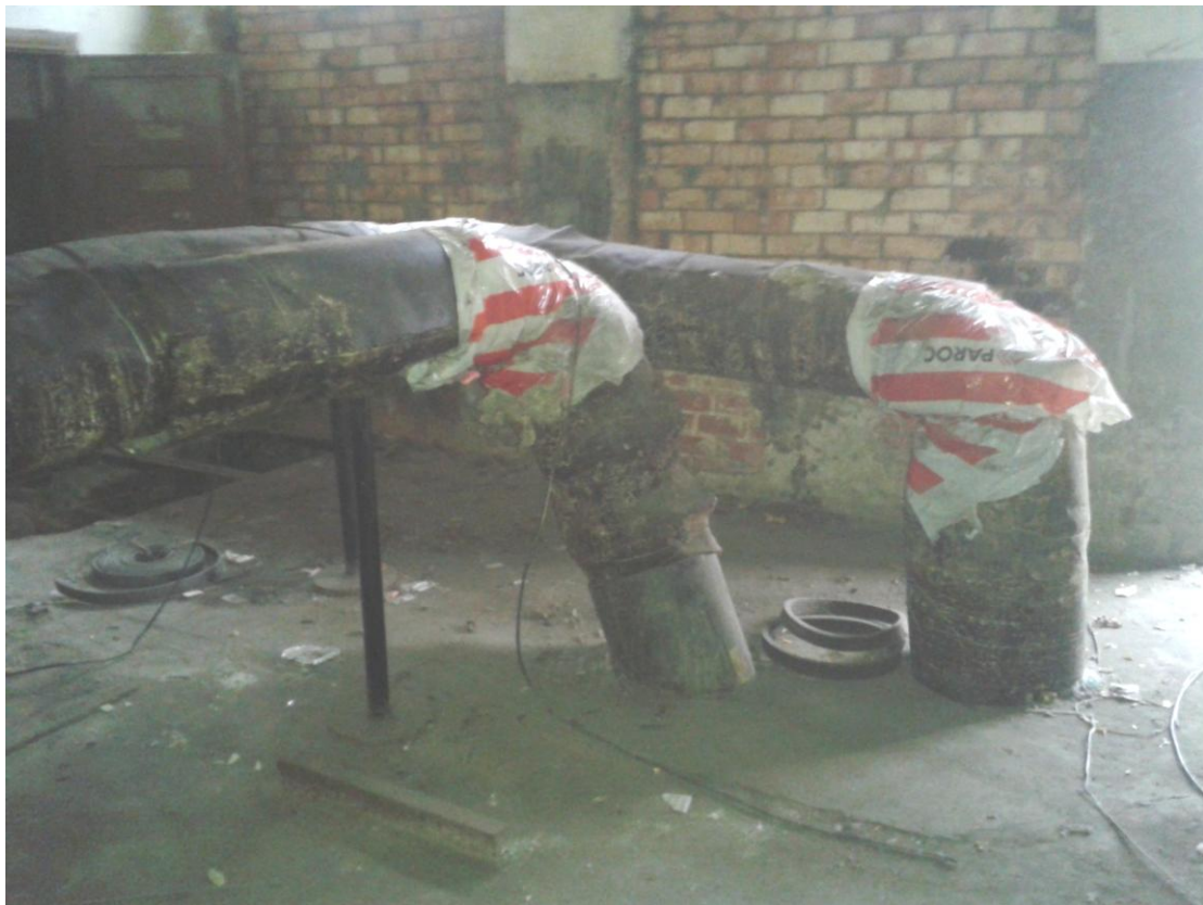
iltumtrases cauruļu virszemes posms
