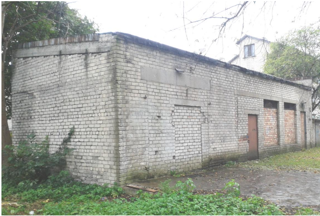
Katlu mājas fasāde, ar priekšplānā redzamiem bijušās katlu mājas pamatiem un betona grīdu
