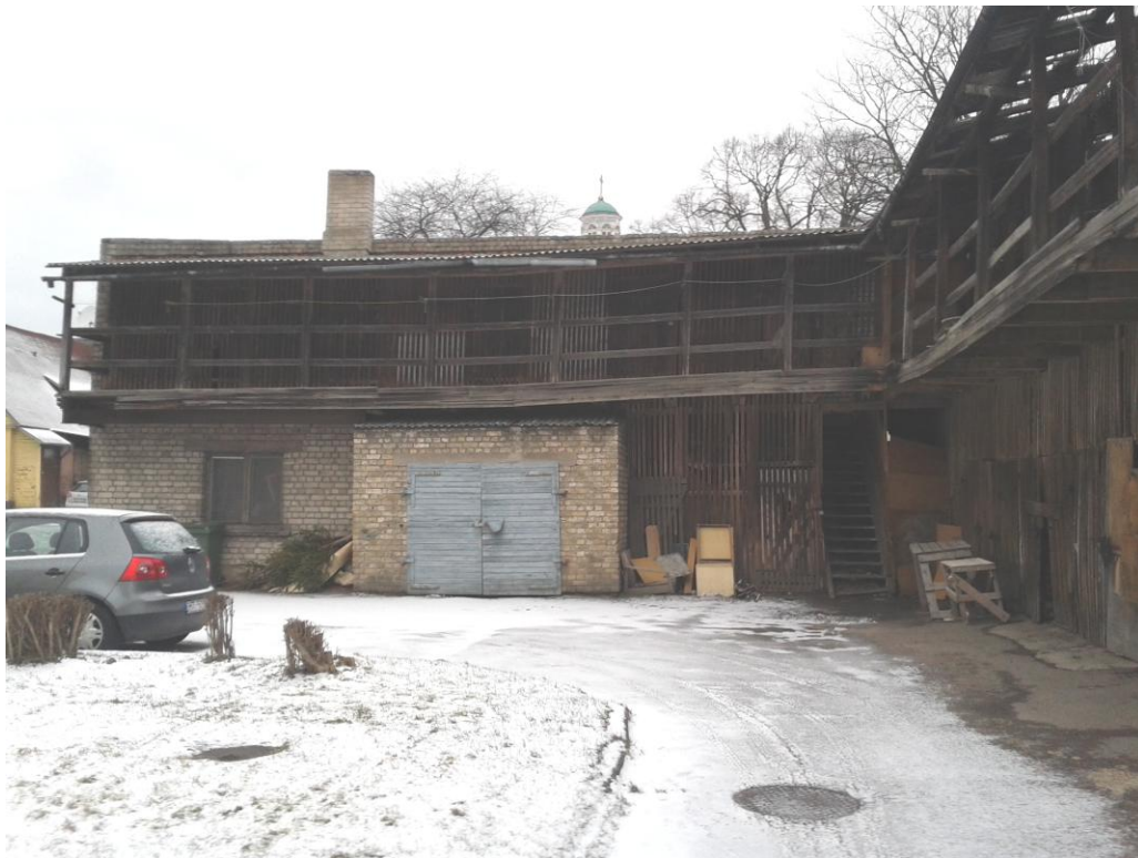
Skats uz malkas šķūņiem, (zem trepēm uz otro stāvu – siltumtrases ievads katlu mājā)
