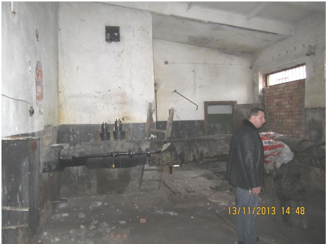
Siltumtrases cauruļu virszemes posms ūtlu mājas iekšpusē
