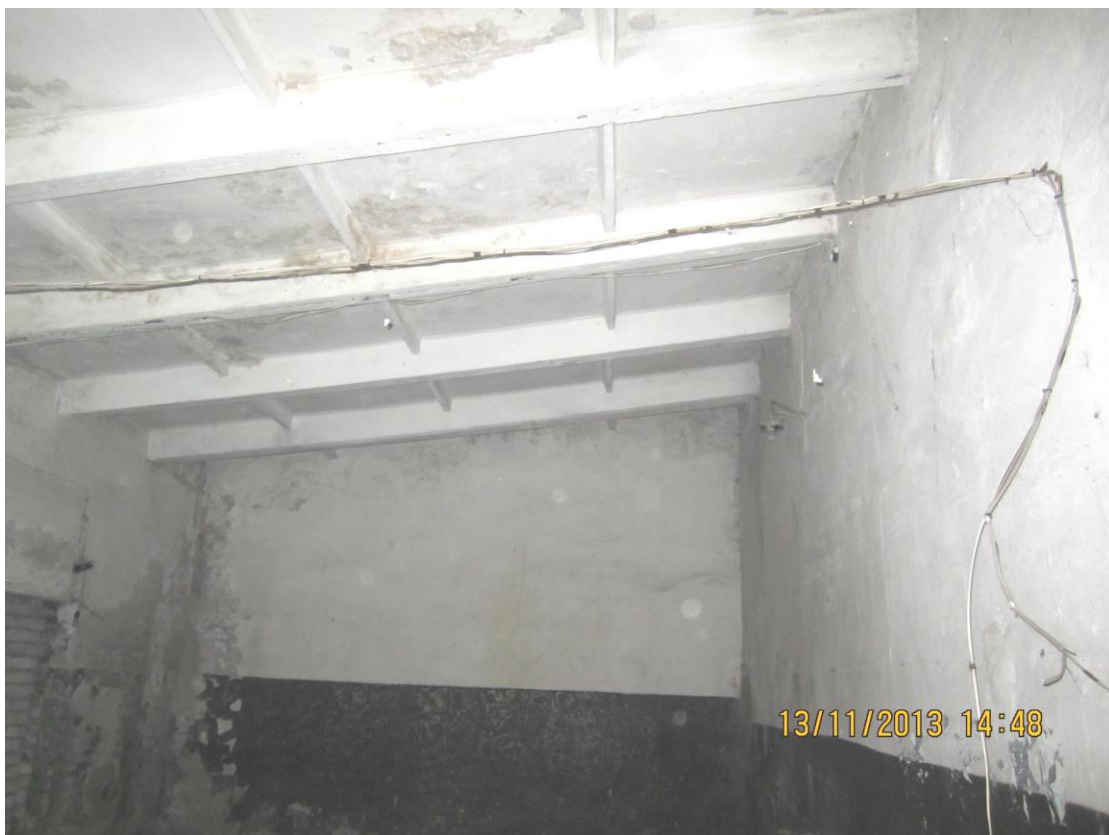
Riboto dzelzbetona paneļu pārsegums
