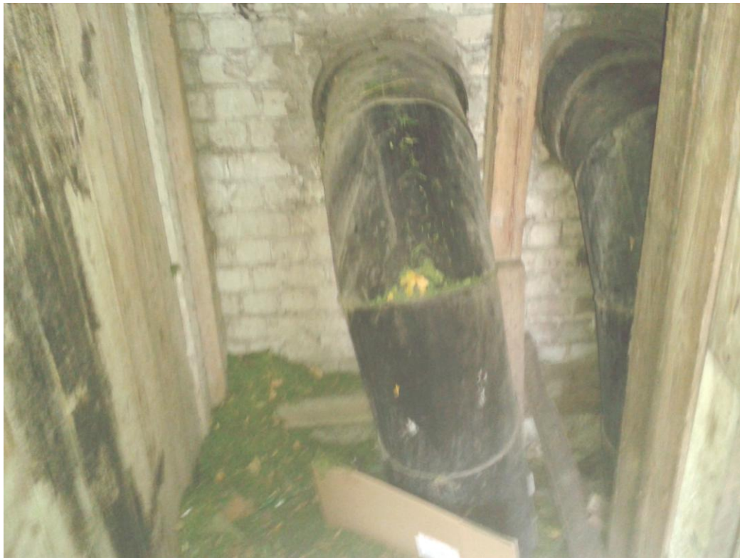
Siltumtrases ievads katlu mājā (skats no malkas šķūnīšu puses, patrepē)
