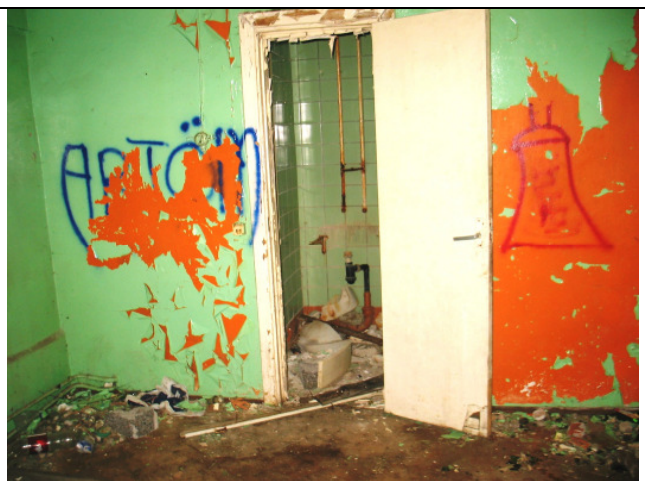
Ar starpsienām nodalītas tehniskās telpas un sanmezgl.
