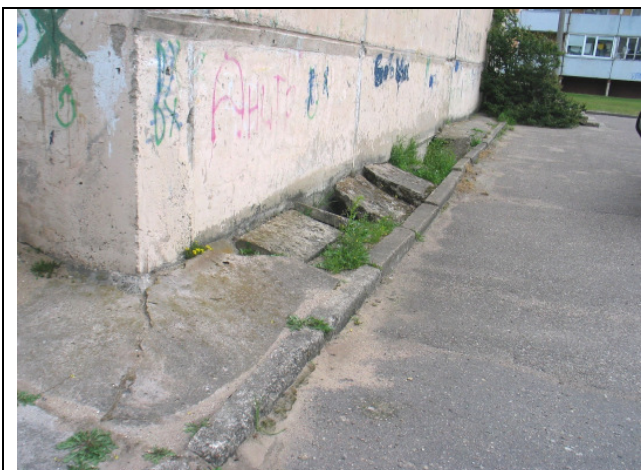
Dienvidaustrumu stūris (bojāta ēkas apmale).
