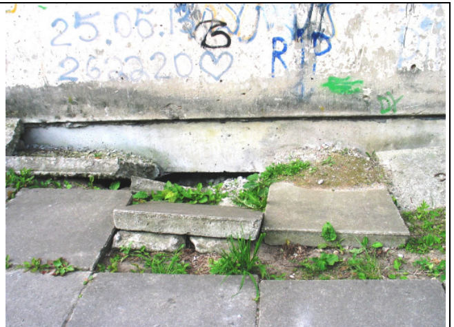
Bojāti pamati, ēkas apmale un ietve nosēdusies
