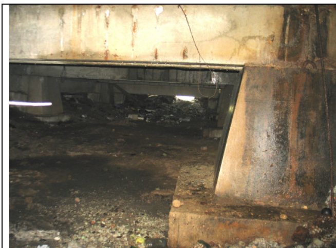
Ēkas pagraba konstrukcijas (bojāti pamati un, sijas)
