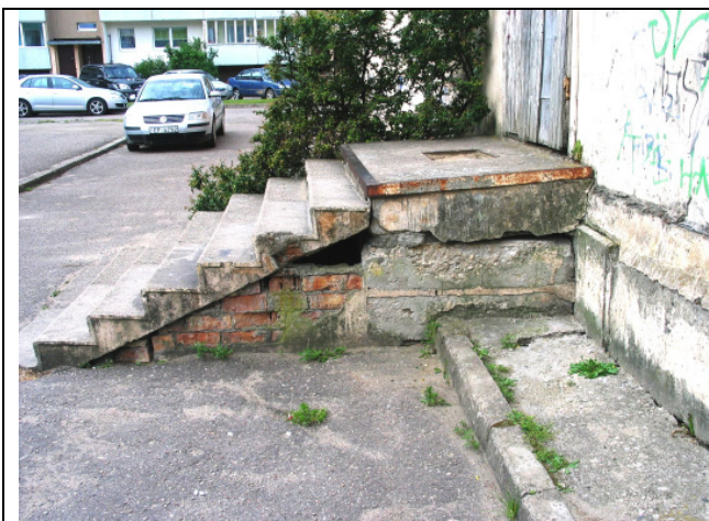
Kāpnes pie austrumu ieejas (bojātas kāpņu konstrukcijas).
