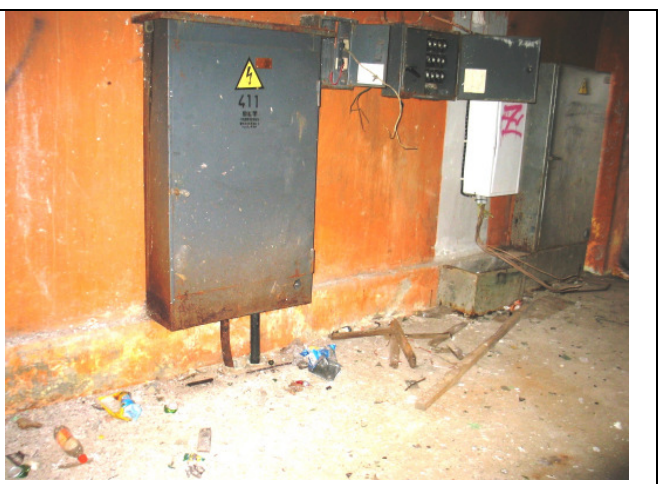
Darbojošās AS „Sadales tīkli” kabeļu sadalnes
