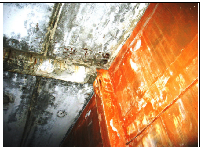
Pārseguma paneļiem atsegts stiegrojums un uz stiegrojuma korozija.
