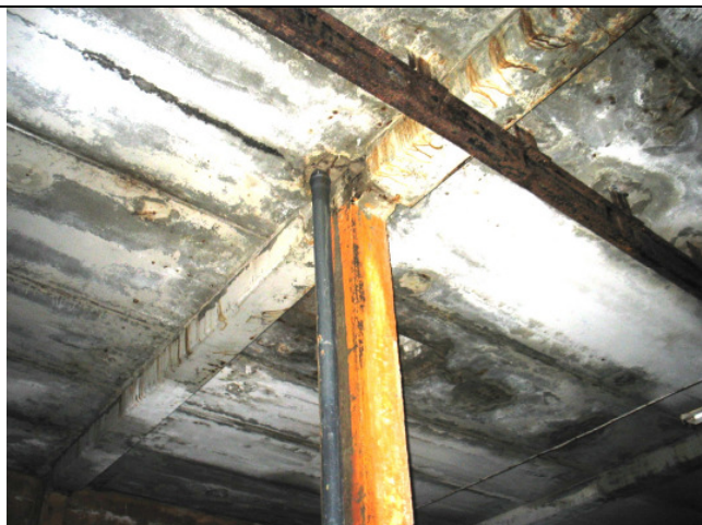
Bojāta notekcaurule no ēkas jumta.
