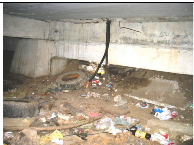
Ēkas pagraba konstrukcijas (bojāti pamati)
