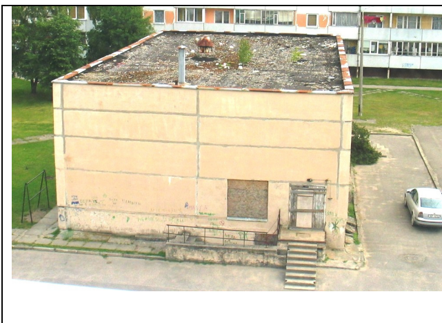
Jumts no dienvidu puses (bojāta jumta segums)
