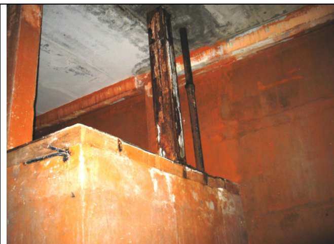
Tehniskās telpas un sanmezglas inženiertīklu izvadi uz ēkas jumta.
