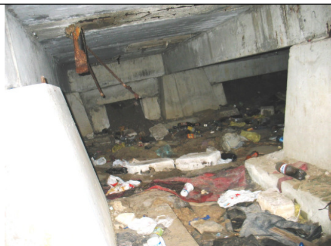
Ēkas pagraba konstrukcijas (pamati, sijas, pārseguma paneļi, pamati notekcaurule no jumta u. c.)
