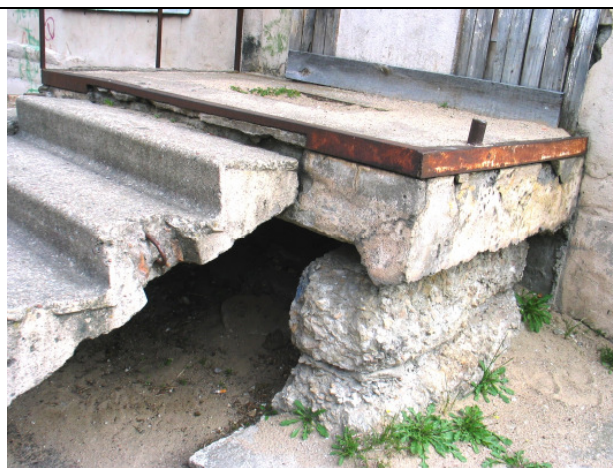
Kāpnes pie dienvidu ieejas (bojātas kāpņu konstrukcijas).
