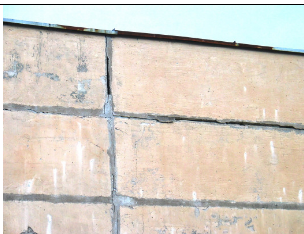
Izdrupušas sienu paneļu savienojumu šuves, panelis pakustējies
