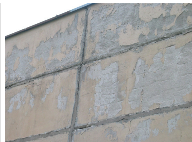
Nolupusi krāsa, nodrupis apmetums, izdrupušas sienu paneļu savienojumu šuves
