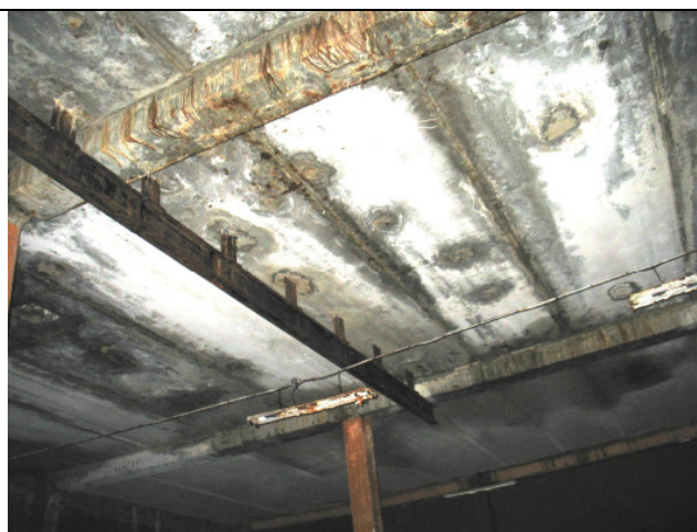
Kolonām un sijām atsegts stiegrojums un uz stiegrojuma korozija.
