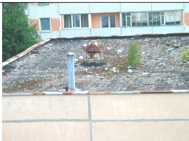
Jumts no dienvidu puses (bojāti jumta elementi)
