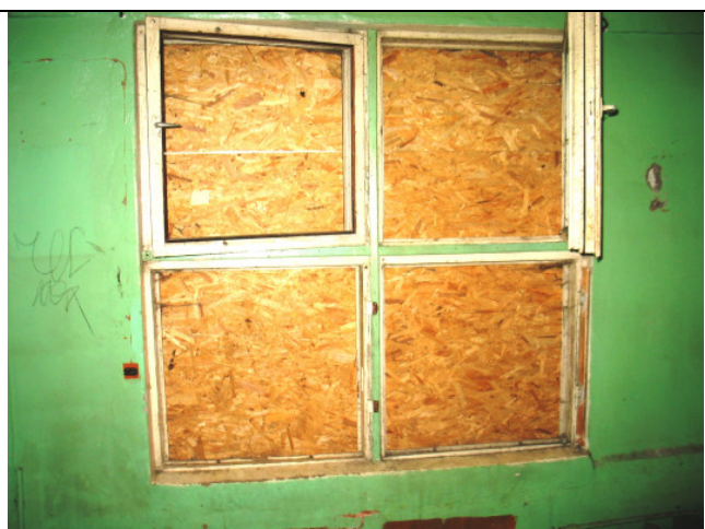
Logi aizskrūvēti ar skaidu plātnēm
