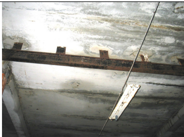
Telfera sija, nedarbojošies apgaismojuma elementi.
