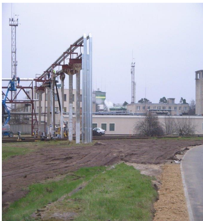
Maģistrālās siltumtrases rekonstrukcija posmā no nekustamā īpašuma Talsu ielā 69, Ventspilī līdz nekustamajam īpašumam Dzintaru ielā 88, Ventspilī 4.posms
