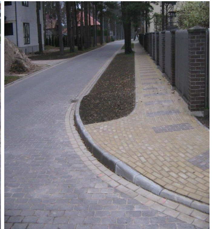
Siltumtrases rekonstrukcija Dzeņu un Lakstīgalu ielā, Ventspilī
