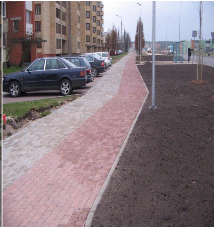
Siltumtīklu rekonstrukcija no ēkas Celtnieku ielā 8 līdz ēkām Rindas ielā 50 un Siguldas ielā 29 (3.etaps)
