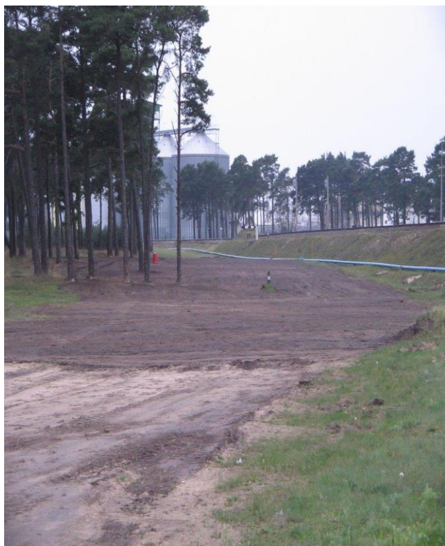
Maģistrālās siltumtrases rekonstrukcija posmā no nekustamā īpašuma Talsu ielā 69, Ventspilī līdz nekustamajam īpašumam Dzintaru ielā 88, Ventspilī 2.posms
