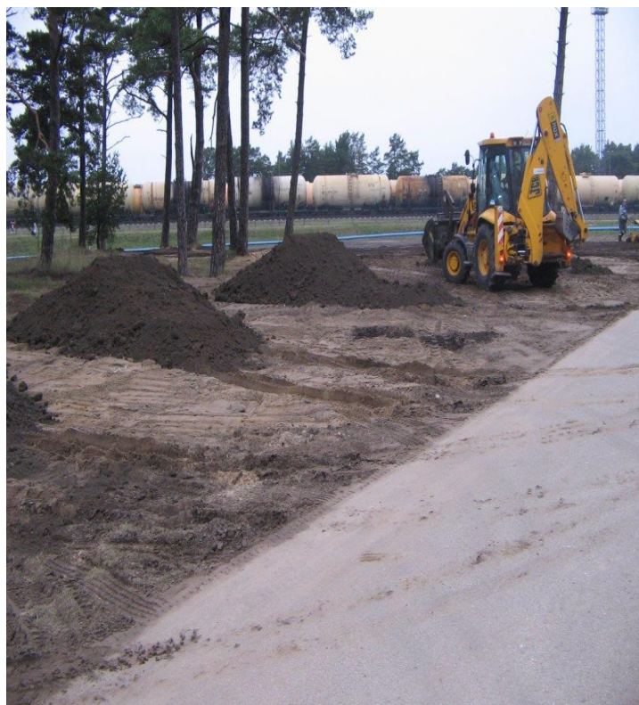
Maģistrālās siltumtrases rekonstrukcija posmā no nekustamā īpašuma Talsu ielā 69, Ventspilī līdz nekustamajam īpašumam Dzintaru ielā 88, Ventspilī 2.posms
