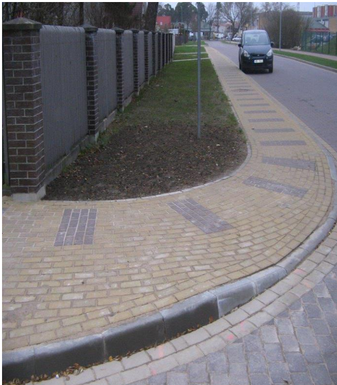
Siltumtrases rekonstrukcija Dzeņu un Lakstīgalu ielā, Ventspilī
