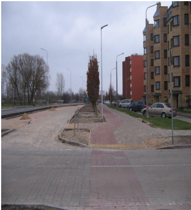
Siltumtīklu rekonstrukcija no ēkas Celtnieku ielā 8 līdz ēkām Rindas ielā 50 un Siguldas ielā 29 (3.etaps)
