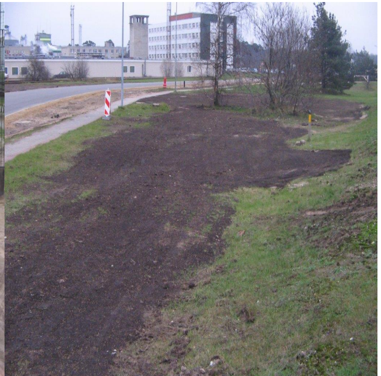
Maģistrālās siltumtrases rekonstrukcija posmā no nekustamā īpašuma Talsu ielā 69, Ventspilī līdz nekustamajam īpašumam Dzintaru ielā 88, Ventspilī 5.posms
