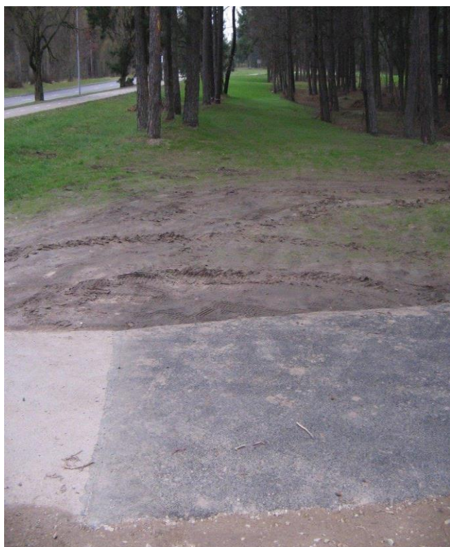
Siltumtrases rekonstrukcija no maģistrālās gaisa siltumtrases līdz Talsu ielai 112, Ventspilī
