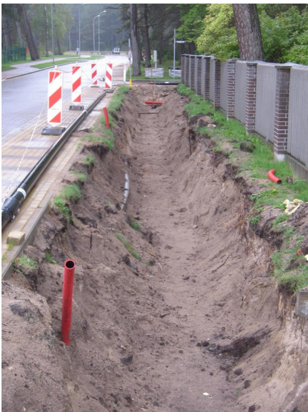
Siltumtrases rekonstrukcija Dzeņu un Lakstīgalu ielā, Ventspilī
