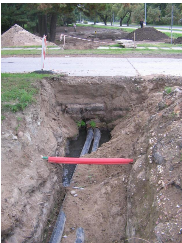
Siltumtrases rekonstrukcija no maģistrālās gaisa siltumtrases līdz Talsu ielai 112, Ventspilī
