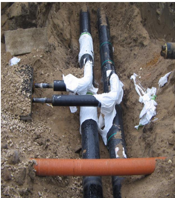
Maģistrālās siltumtrases rekonstrukcija posmā no nekustamā īpašuma Talsu ielā 69, Ventspilī līdz nekustamajam īpašumam Dzintaru ielā 88, Ventspilī 2.posms
