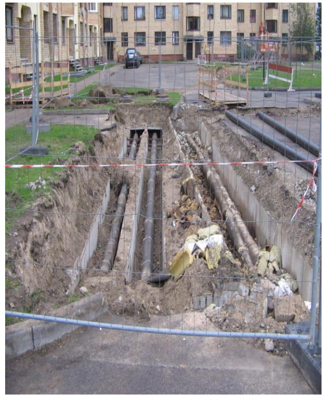
Siltumtīklu rekonstrukcija no ēkas Celtnieku ielā 8 līdz ēkām Rindas ielā 50 un Siguldas ielā 29 (3.etaps)
