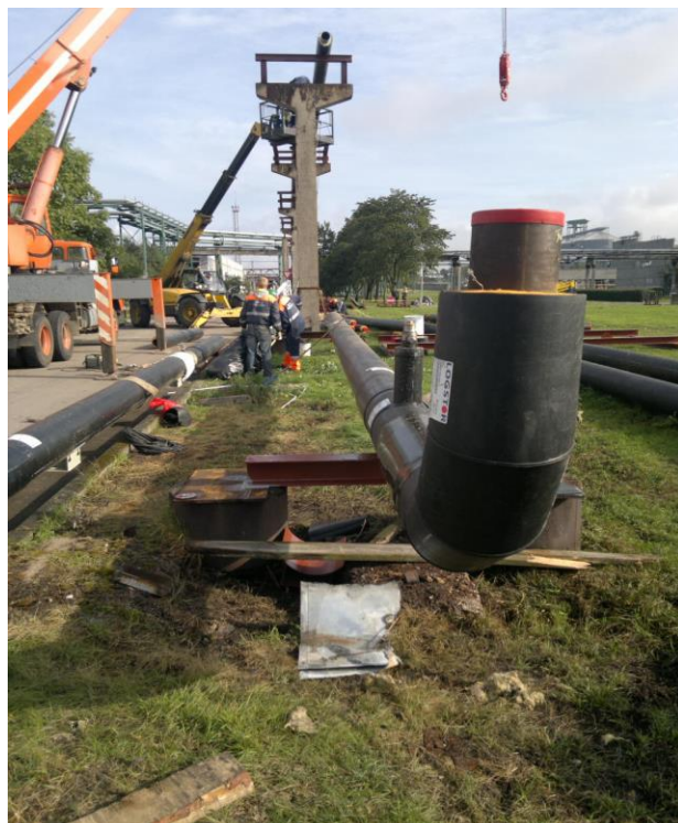
Maģistrālās siltumtrases rekonstrukcija posmā no nekustamā īpašuma Talsu ielā 69, Ventspilī līdz nekustamajam īpašumam Dzintaru ielā 88, Ventspilī 4.posms
