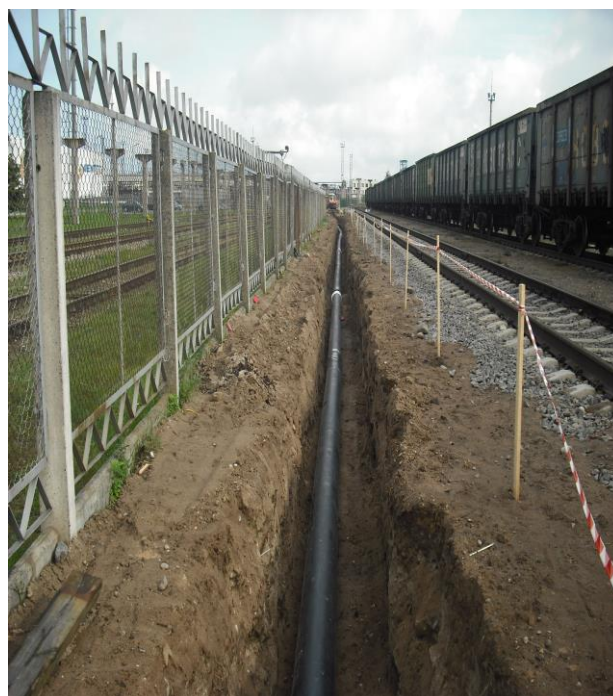
Maģistrālās siltumtrases rekonstrukcija posmā no nekustamā īpašuma Talsu ielā 69, Ventspilī līdz nekustamajam īpašumam Dzintaru ielā 88, Ventspilī 5.posms
