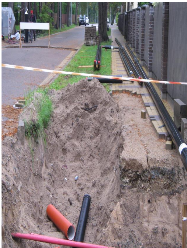
Siltumtrases rekonstrukcija Dzeņu un Lakstīgalu ielā, Ventspilī
