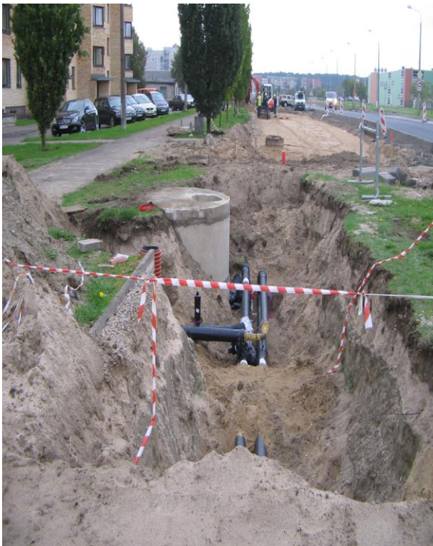
Siltumtīklu rekonstrukcija no ēkas Celtnieku ielā 8 līdz ēkām Rindas ielā 50 un Siguldas ielā 29 (3.etaps)
