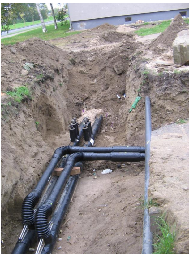
Siltumtīklu rekonstrukcija Ventspilī no Siguldas ielas Nr.25 līdz Siguldas ielai Nr.23, Nr.21, Nr.19
