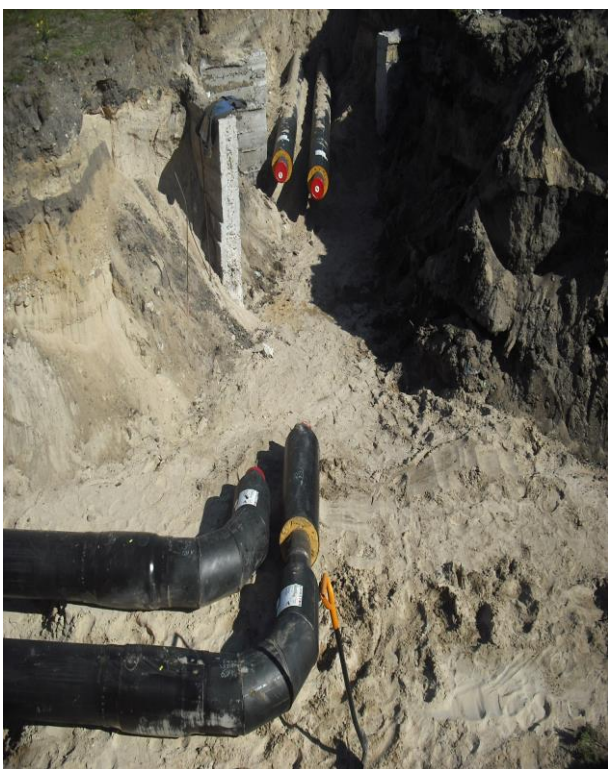
Maģistrālās siltumtrases rekonstrukcija posmā no nekustamā īpašuma Talsu ielā 69, Ventspilī līdz nekustamajam īpašumam Dzintaru ielā 88, Ventspilī 3.posms
