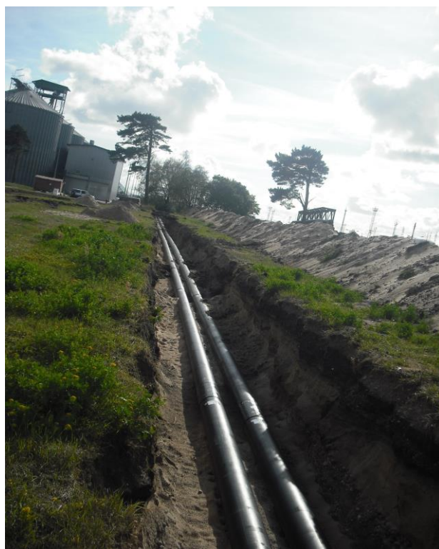
Maģistrālās siltumtrases rekonstrukcija posmā no nekustamā īpašuma Talsu ielā 69, Ventspilī līdz nekustamajam īpašumam Dzintaru ielā 88, Ventspilī 3.posms
