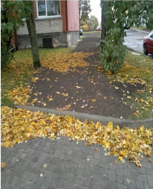
Siltumtīklu rekonstrukcija Ventspilī no Siguldas ielas Nr.22 līdz Siguldas ielai Nr.20,16/18, 14, 12a, 12
