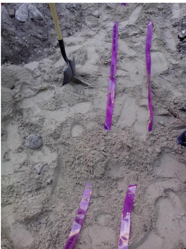
Siltumtīklu rekonstrukcija Ventspilī starp ēkām Talsu ielā Nr.35 Siltumtīklu rekonstrukcija
