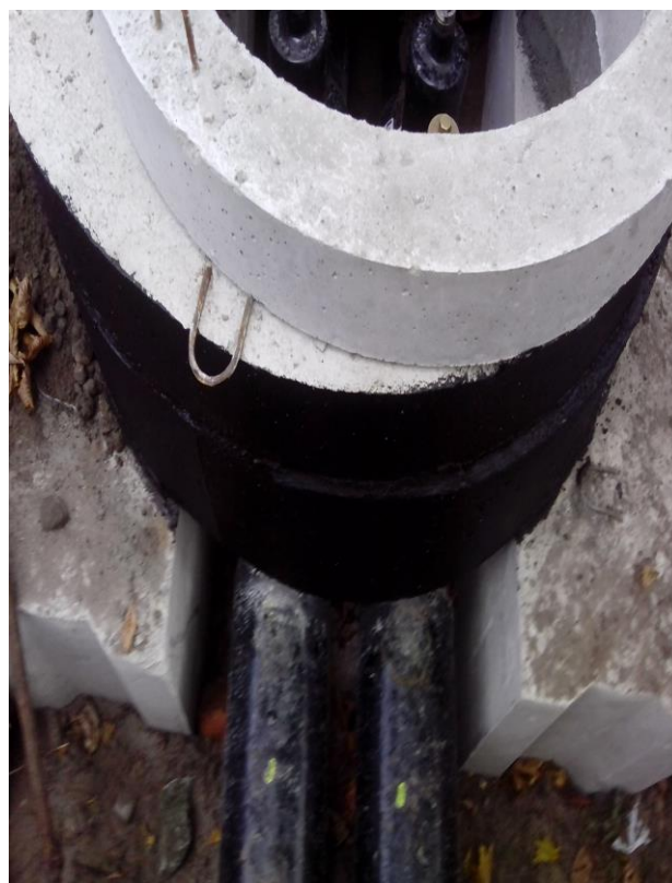
Siltumtīklu rekonstrukcija Ventspilī starp ēkām Talsu ielā Nr.35, Nr.37, Nr.39
