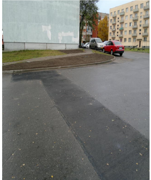
Siltumtīklu rekonstrukcija Ventspilī no Siguldas ielas Nr.22 līdz Siguldas ielai Nr.20,16/18, 14, 12a, 12
