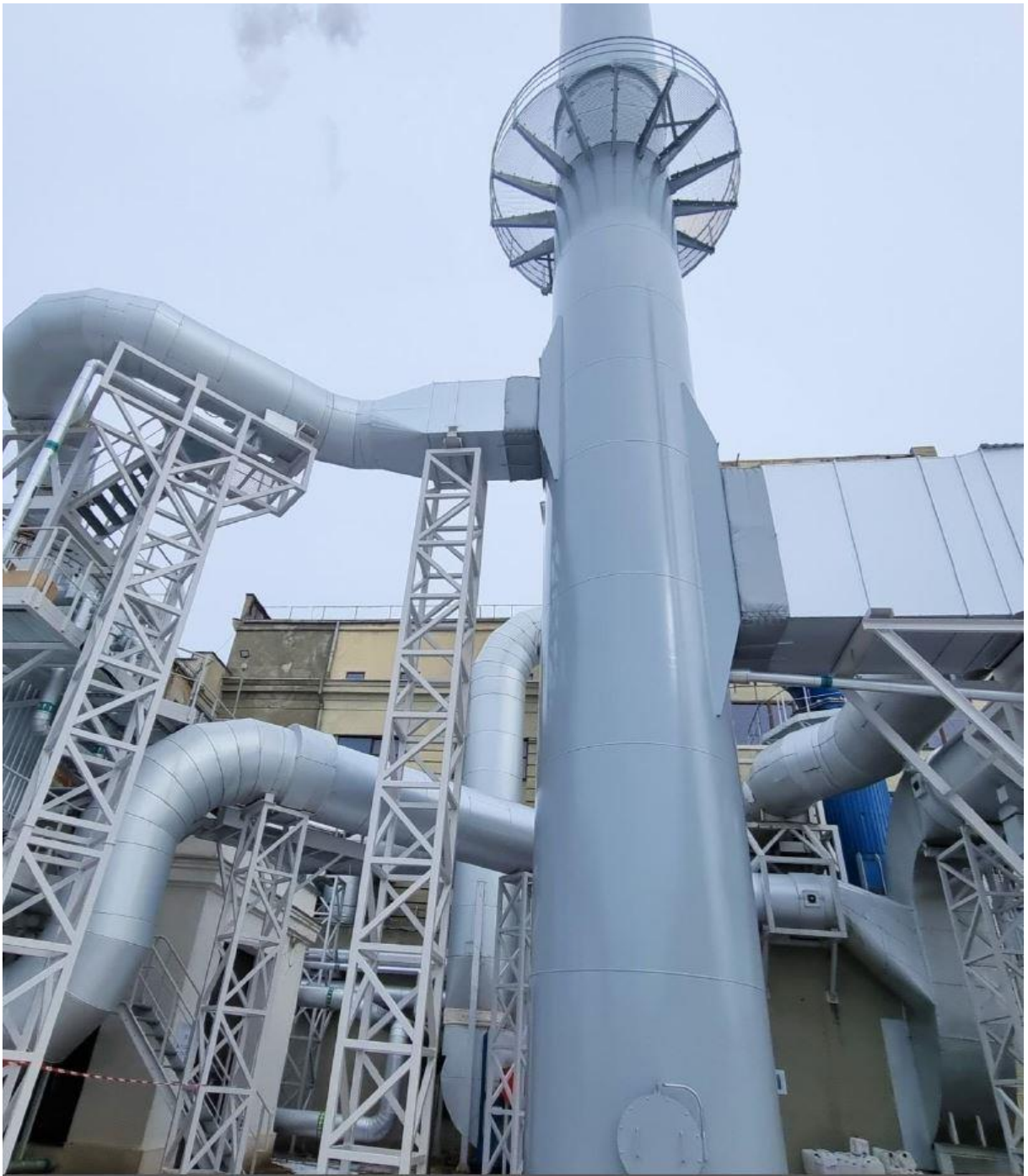
12. attēls. Kauņas Enerģija, Lietuva (efektivitātes sistēmas izstrāde un uzstādīšana, kas papildus piegādāja siltuma jaudu \geq 2,4 MW)
