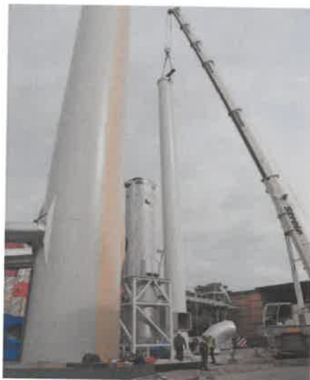
6.1. att. Dūmgāzu kondensatora uzstādīšana Brīvības ielā 38.
