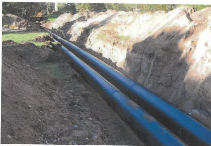
6.2. att. Siltumtīklu rekonstrukcija.
