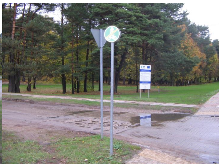
Siltumtrases rekonstrukcija no maģistrālās gaisa siltumtrases līdz Talsu ielai 112, Ventspilī
