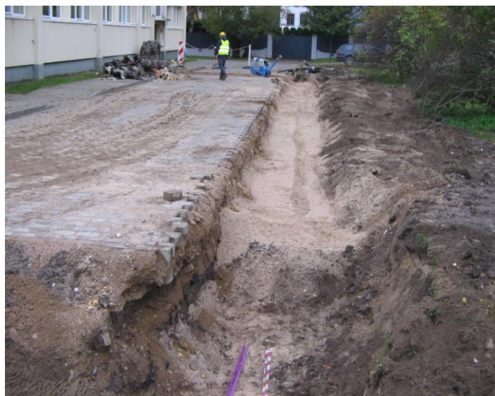
Siltumtrases rekonstrukcija Dzeņu un Lakstīgalu ielā, Ventspilī
