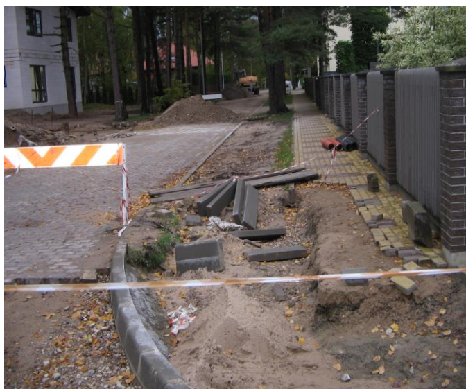
Siltumtrases rekonstrukcija Dzeņu un Lakstīgalu ielā, Ventspilī
