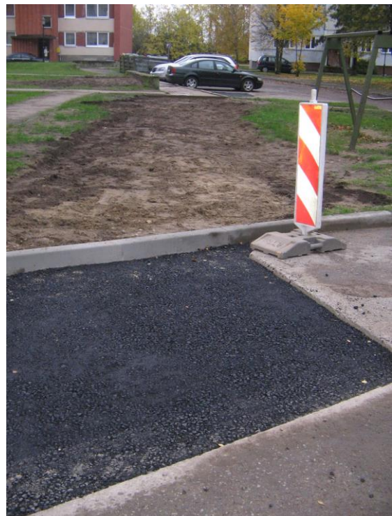
Siltumtīklu rekonstrukcija no ēkas Celtnieku ielā 8 līdz ēkām Rindas ielā 50 un Siguldas ielā 29 (3.etaps)
