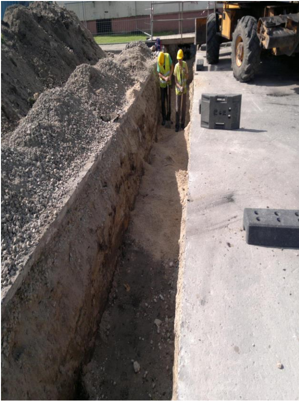
Siltumtīklu rekonstrukcija Ventspilī no Siguldas ielas Nr.22 līdz Siguldas ielai Nr.20,16/18, 14, 12a, 12
