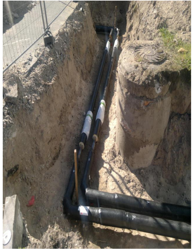
Siltumtīklu rekonstrukcija Ventspilī no Siguldas ielas Nr.22 līdz Siguldas ielai Nr.20,16/18, 14, 12a, 12
