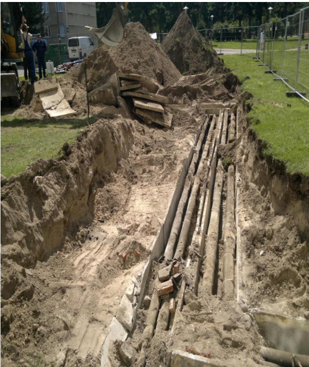
Siltumtrase rekonstrukcija starp ēkām Saules ielā Nr.106, Nr.114 un Nr.116, Ventspilī
